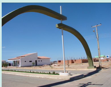
Portal do "Consórcio das Águas"
